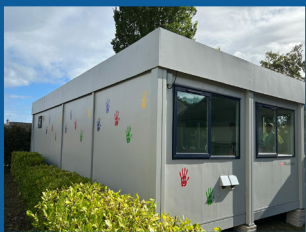
La classe de Laure Plouzénec pendant la durée des travaux de l'école maternelle Simone Veil.
