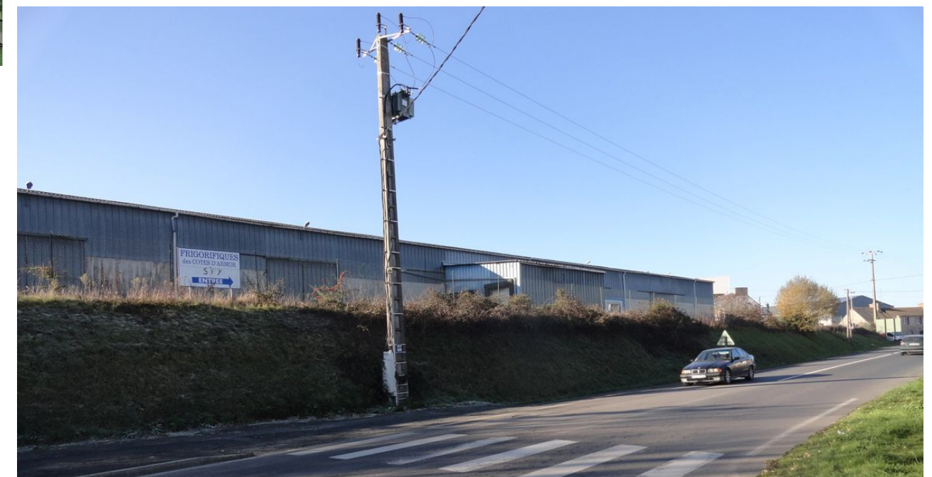
Photo 3 : Hangar frigorifique bordé par un talus
