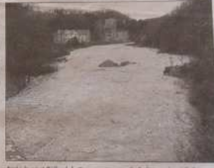
Après le pont Hilland, le goussier a gagné plusieurs mètres de largeur et est en fait au niveau de l'usine hydroélectrique.
