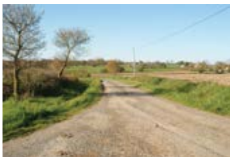
Travaux de réfection de chaussée sur la route du Pont Ranton
