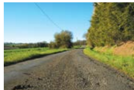
Travaux de réfection de chaussée sur la route de Bien y Vient
