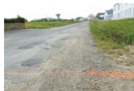
Aménagement de trottoirs et réfection de la voirie rue du Dernier Sou
