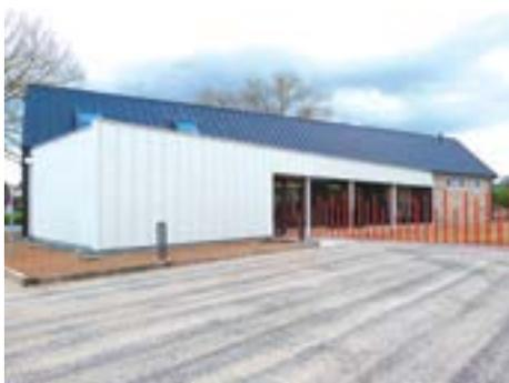
Le bâtiment, conçu par le cabinet Garçonnet de Langueux, est en ossature bois et constitué d'un bardage en zinc. Le pignon sud a été rénové en pierres. D'une surface de près de 300 m<sup>2</sup>, la salle est équipée d'une cuisine et permet l'accueil de 100 personnes dans d'agréables conditions pour des manifestations associatives et privées. Un espace jardin et une terrasse sont attenants au bâtiment.
