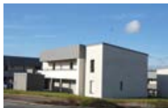
Les logements sociaux de l'impasse des Ficaïres
