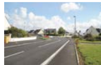
Réaménagement du lotissement des Grèves
