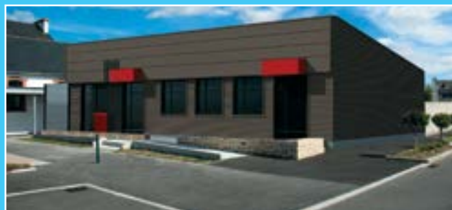
Le bardage de la salle du Trait d'Union et le remplacement des menuiseries extérieures permettront à la fois de rajeunir et d'isoler le bâtiment. Coût : 65 000 € TTC
