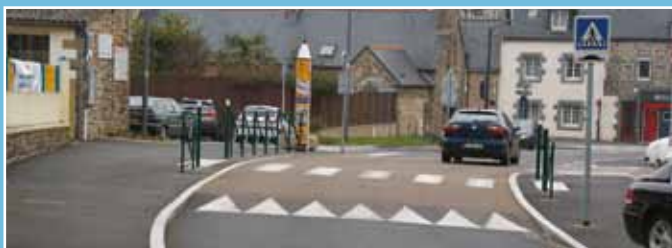
Des aménagements de sécurité comme ceux réalisés rue de Plédran (photo) vont être effectués avenue de St-Brieuc (La Croix-Bertrand)
